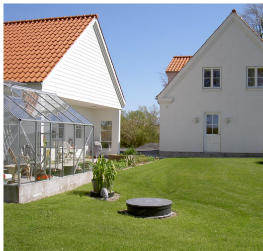
BDT installerat vid ett enfamiljshus
