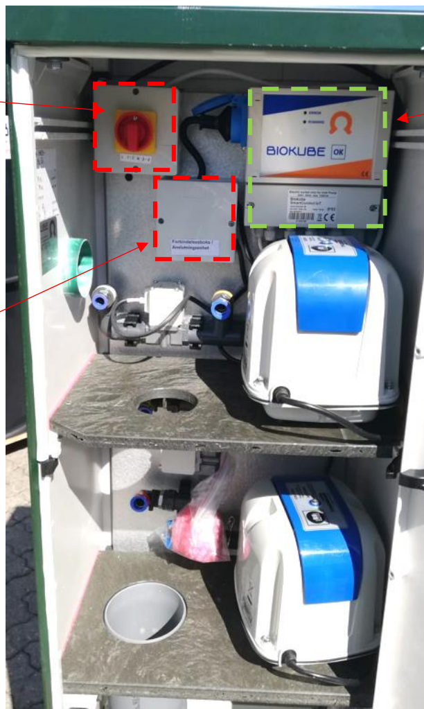
El- och kabelanslutningspunkter i det externa teknikskåpet
