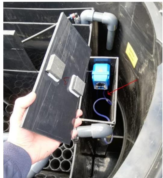
Bilden visar den indbyggda tanken för fosforfällningsmedel inklusive inbyggd doseringspump
