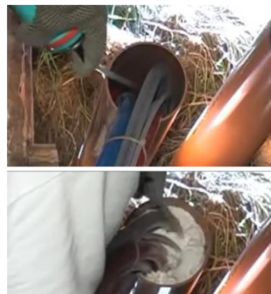
Skumning av anslutningsrör mellan reningsverk och styrskaåp, för att göra dessa lufttäta
