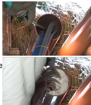
Tätning av blyrör med teknikbox för att göra det lufttätt
